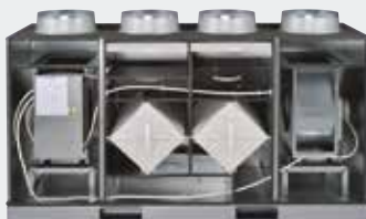
Rimozione dei pannelli frontali
