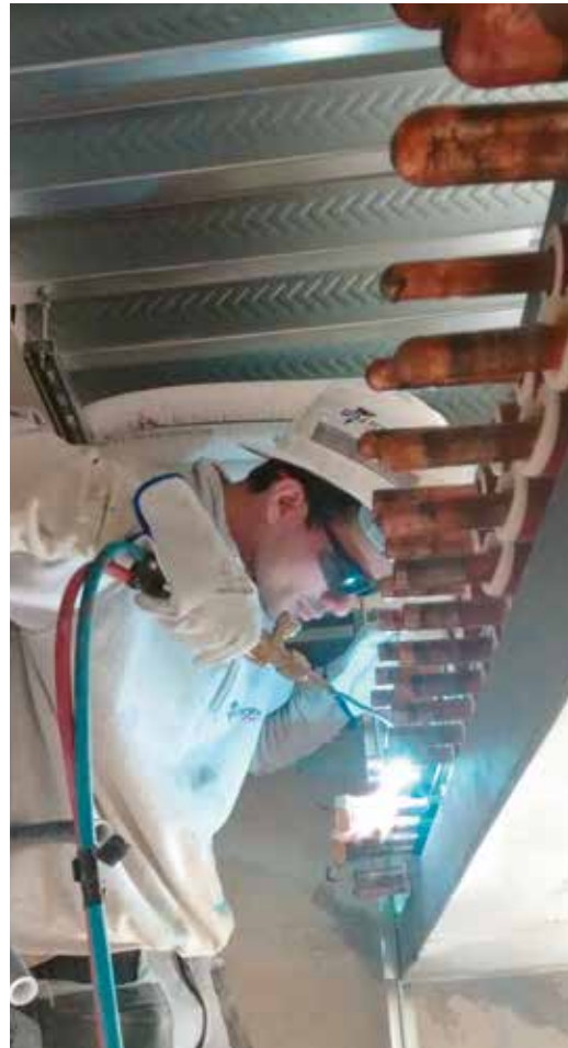
Dettaglio installativo del Distributore Ibrido HBC
